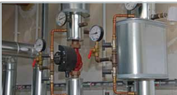
Heizkreis für Bauteil B mit Grundfos MAGNA (Bildnachweis: Grundfos)
